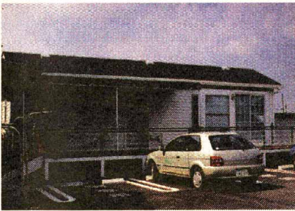
トレーラーハウス
